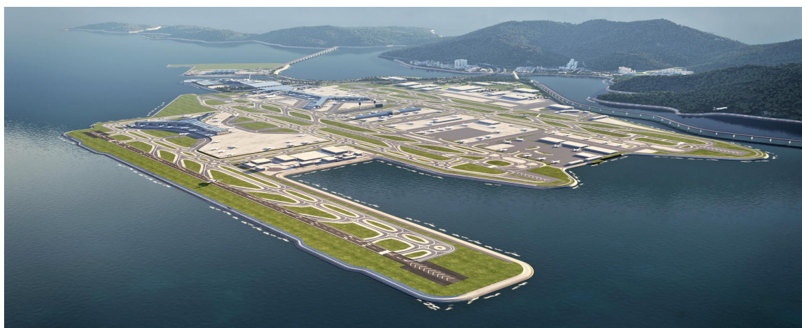
香港国际机场三跑道系统工程
