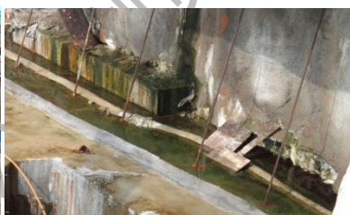
图 5 基坑侧壁腰梁面海水渗漏积水
