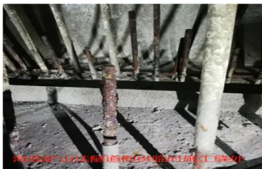
图 7 海底隧道仰拱施工缝处钢筋锈蚀
