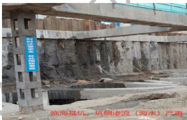
图 4 基坑临海面侧壁海水渗漏
