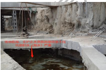
图 6 基坑侧壁海水渗漏坑底积海水
